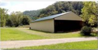
Hay Barn (Metal Construction)
